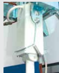
Elektrik motorlu açma mekanizması
